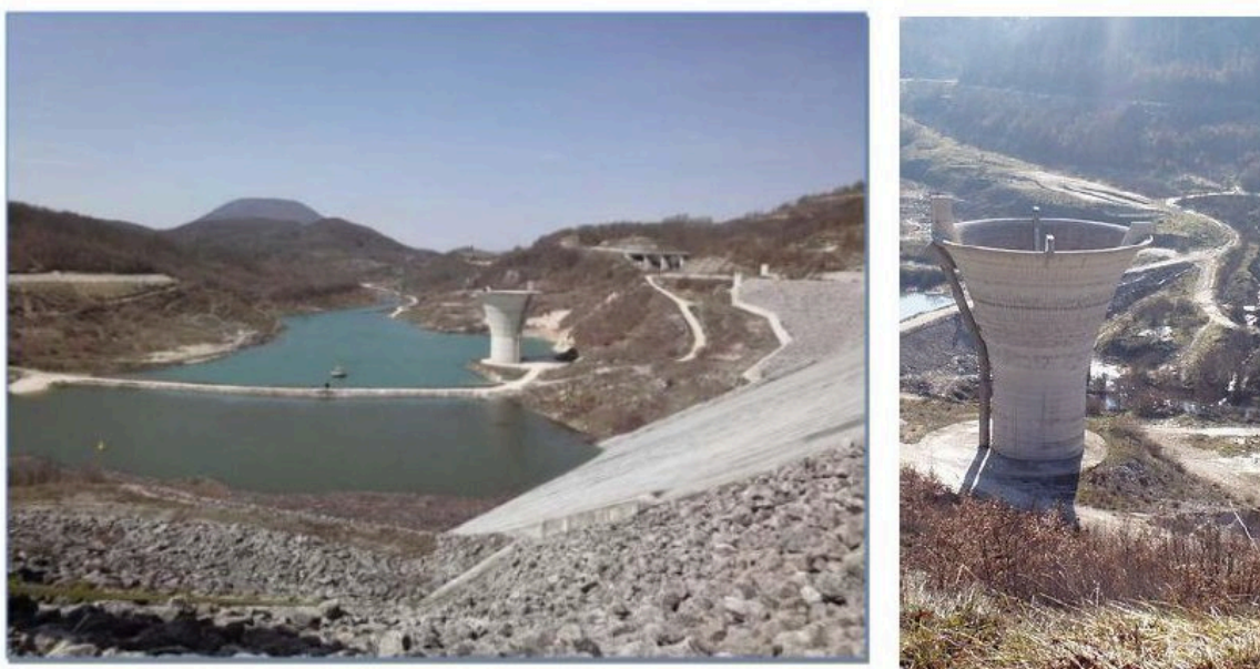
Panoramica della diga di Chiauci (a sx) e particolare dello sfioratore (a dx)
